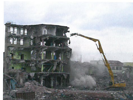
Jako vedlejší produkt nelze využít odpady z demolic, pokud je povinnost prohlásit je odpadem
